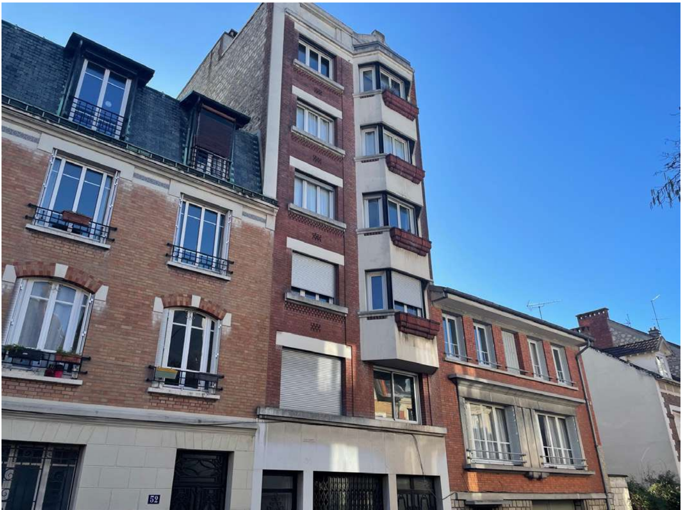
Rénovation d'un immeuble collectif de 7 logements à Paris. © Panasonic
