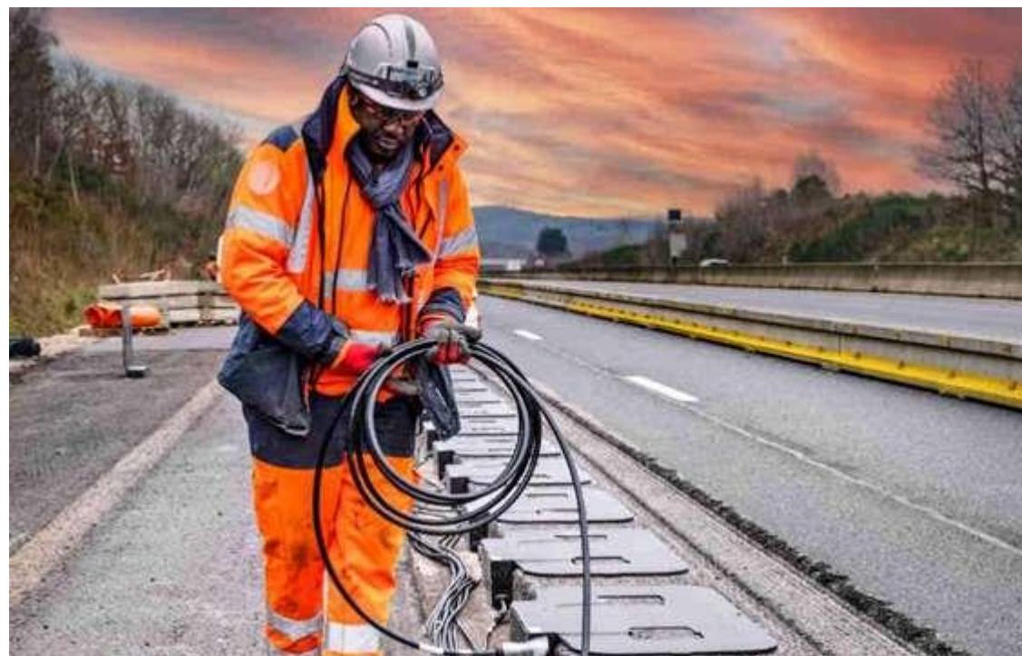
« Charge as you drive » en cours d'aménagement sur l'A10. @ Vinci Autoroutes
