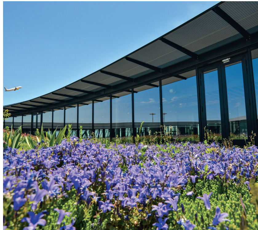
Aéroport de Lyon-Saint Exupéry. © Eric Soudan.
